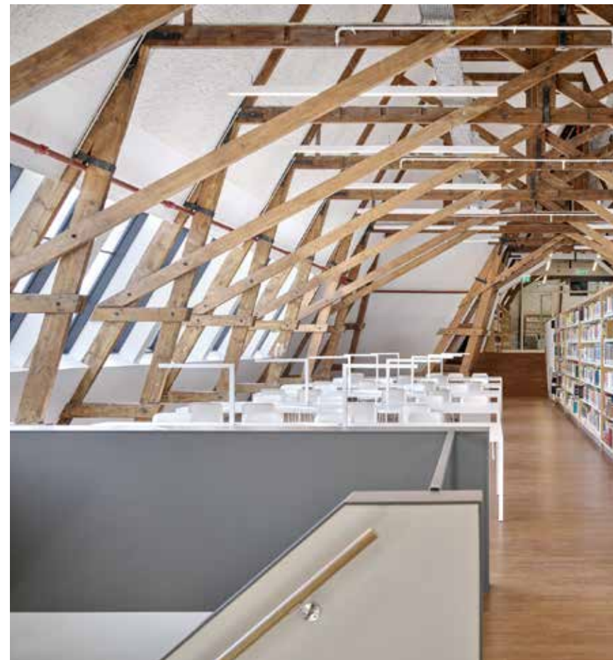
spanten in het zicht / materiaal en kleurgebruik / slim gebruik van de zolderruimte
