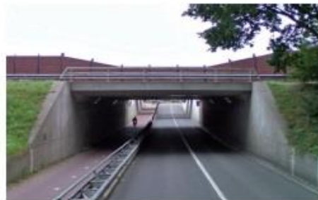
vanaf de van Tuijllstraat richting het noordwesten
