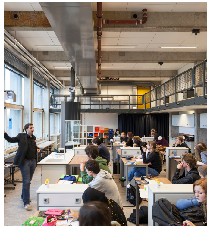
Innovatieve luchtbehandeling met gangen en trappenhuis als retour-kanaal. Cygnus Gymnasium, (Rijksmonument) Amsterdam, WDJArchitecten
