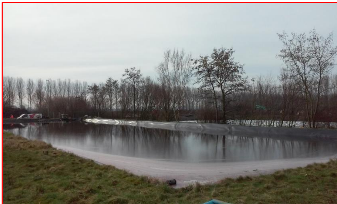
Foto 2. Overzicht vloeistofdicht percolaatbassin
