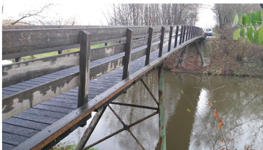
Foto 1: aanzicht bestaande situatie Hoge Brug – Melkvonder Ulft
