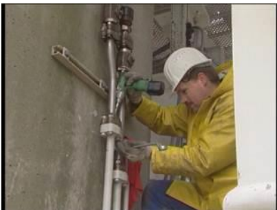
2a. Verlengen hydrauliek (pijler)
