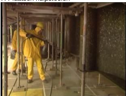
10. Reinigen/stralen
