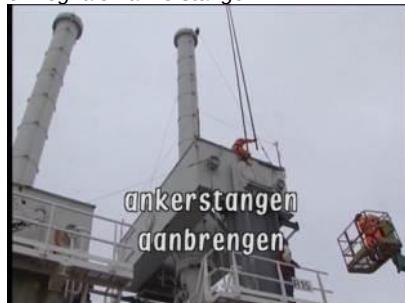
8. Verlengde ankerstangen terugplaatsen
