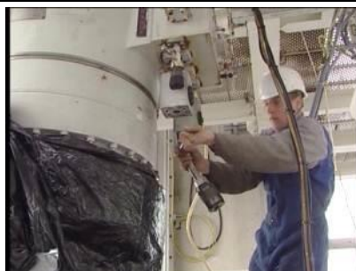
Aansluiting lange slangen op pos.75, pos 76 cilinderzijde.
