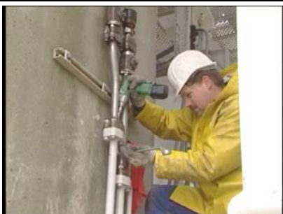
Aansluiten lange slangen aan pijlerzijde.
