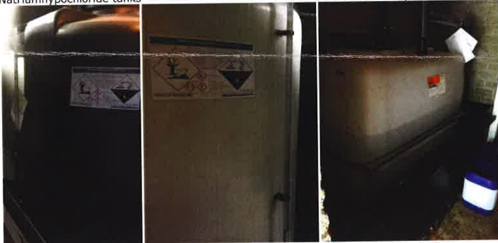
Zwavelzuurtank, enkele vaten vlokmiddel (Locron)
