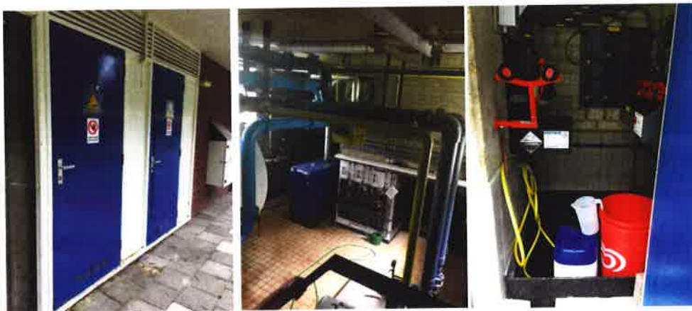
Zwavelzuurtank, enkele vaten vlokmiddel (Locron)
