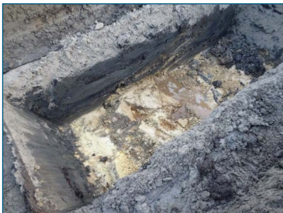
AKU-stortmateriaal in sleuf
