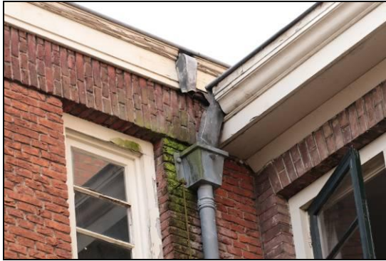
Afbeelding 4: Ruimtes naast regenpijp
