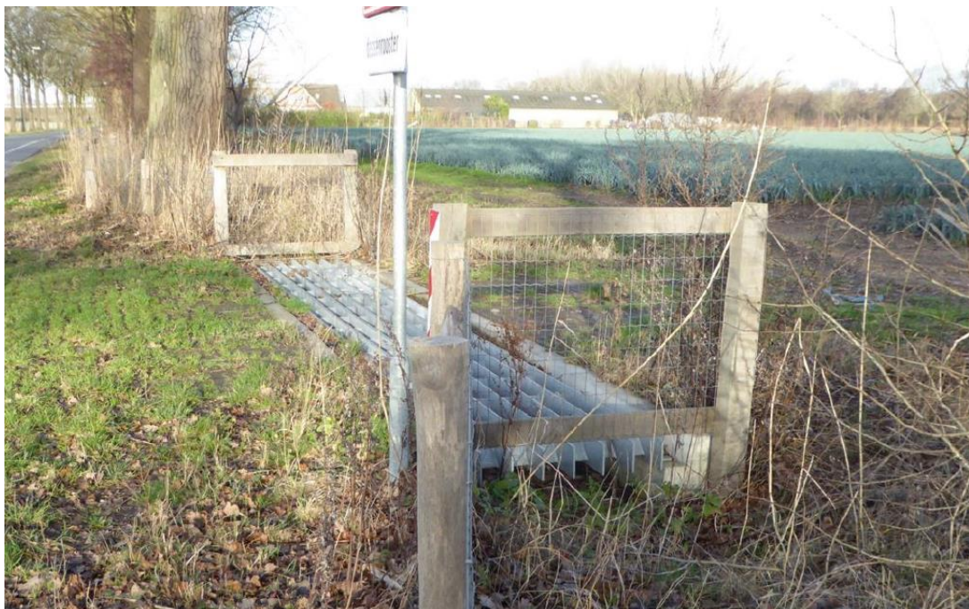
Figuur 4-3: voorbeeld van een dassenraster
