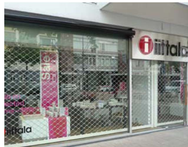
Winkelpuien moeten zo transparant mogelijk; eventuele rolluiken zijn transparant en aan de binnenkant geplaatst
