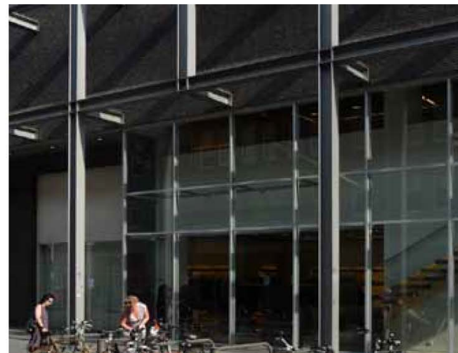
Voorbeelden winkelpuien met metalen profielen en verticale gevelindeling
