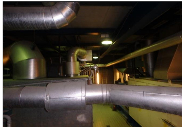
Leidingisolatie Niet asbestverdacht
