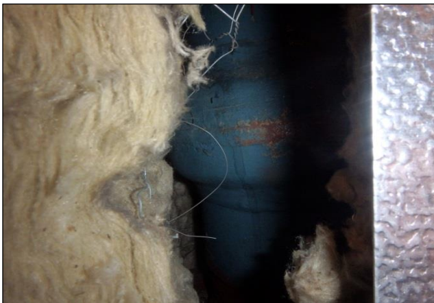
Leidingisolatie Niet asbestverdacht
