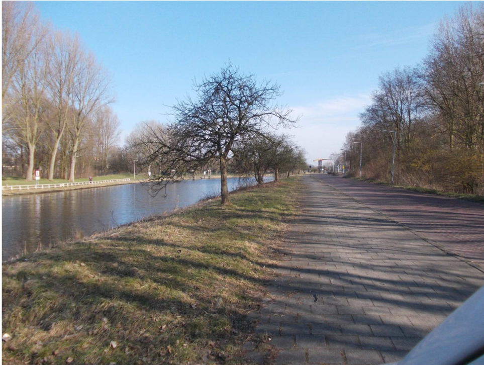
Foto 1: Zicht vanuit zuidwestzijde op ruimtelijke eenheden RE01 t/m RE04.
