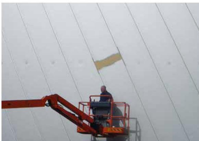
8.12 Beschadigingen en zelfs gaten zijn goed te behandelen en plaatselijk over te spuiten zonder noemenswaardig kleurverschil.
