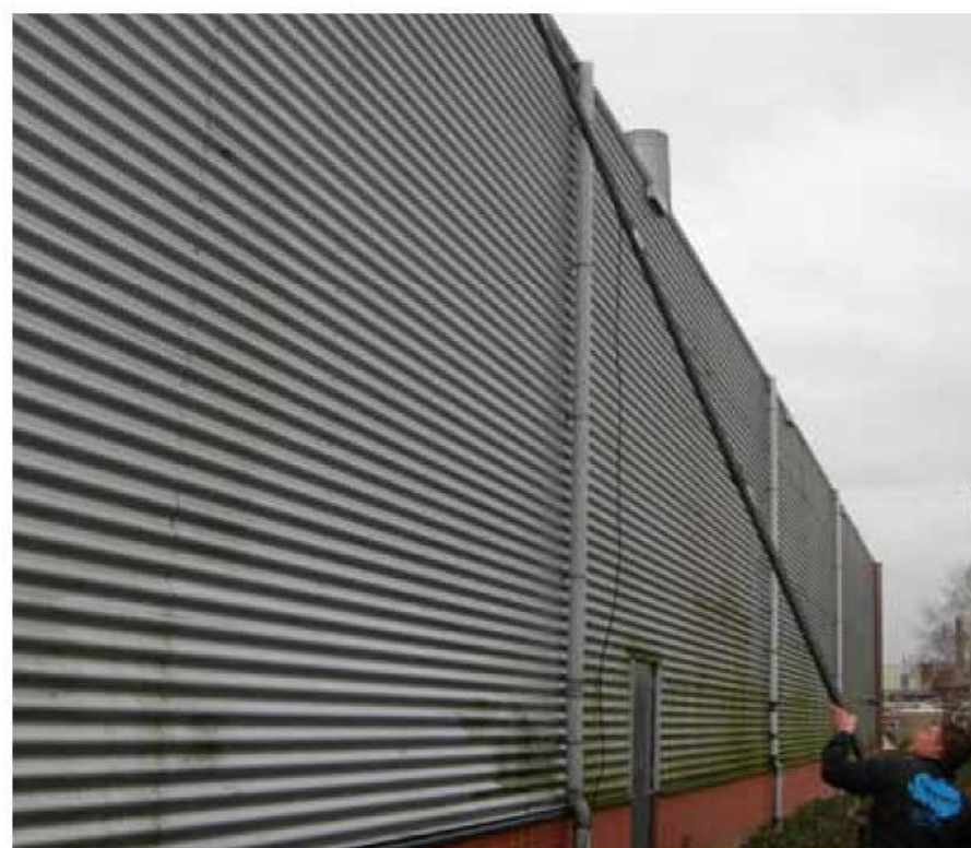
8.6 Het reinigingsmiddel wordt in principe van onder naar boven op een gevel gebracht. De gevel wordt vervolgens van boven naar beneden afgespoeld.
