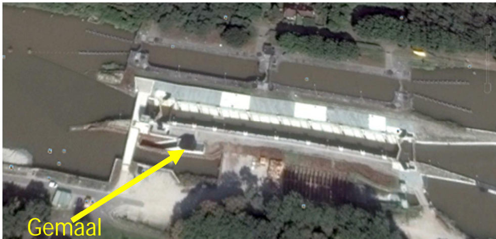
Figuur 1 Luchtfoto Sluiscomplex 3 2016.
