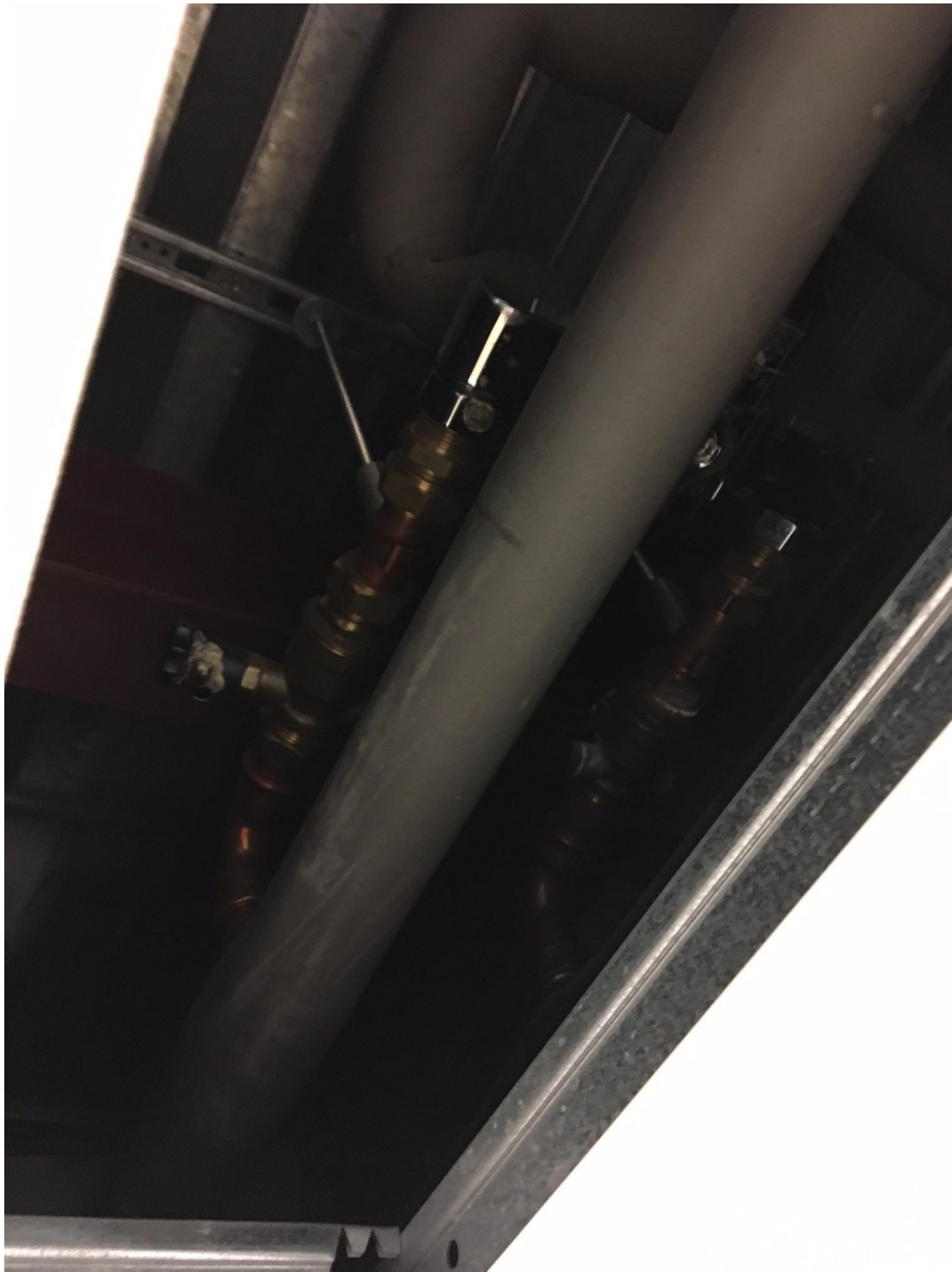
Foto 3: Één van de mengventielen zonder terugstroombeveiligingen.
