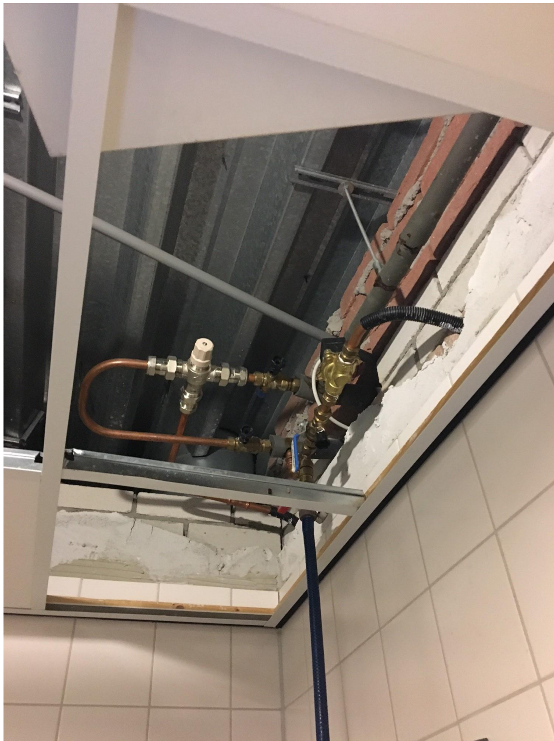
Foto 2: één van de mengventielen zonder terugstroombeveiligingen.
