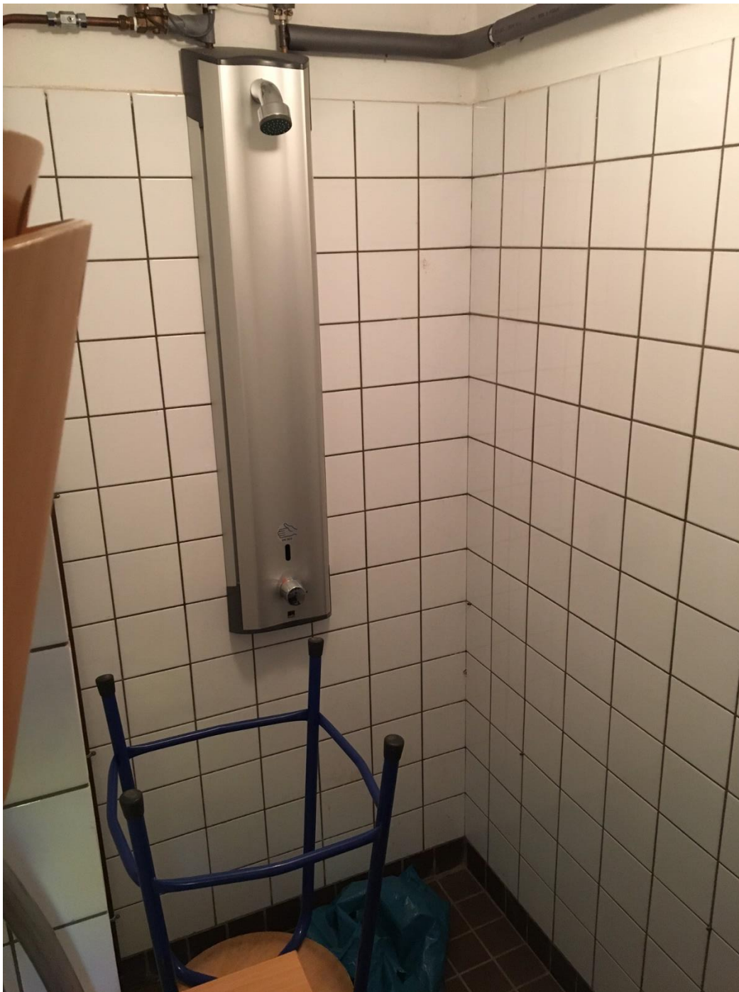
Foto 1: Niet gebruikte douche.
