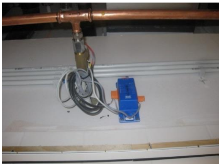
De Melkert (spoelautomaat met magneetklep)
