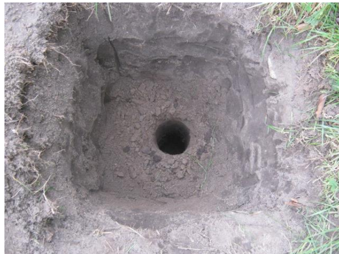
foto 16: inspectiegat kavelpad E278 (2A)
