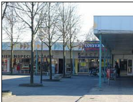
Voorzieningen aan buitenzijde van Winkelcentrum Coevering nabij de entree
