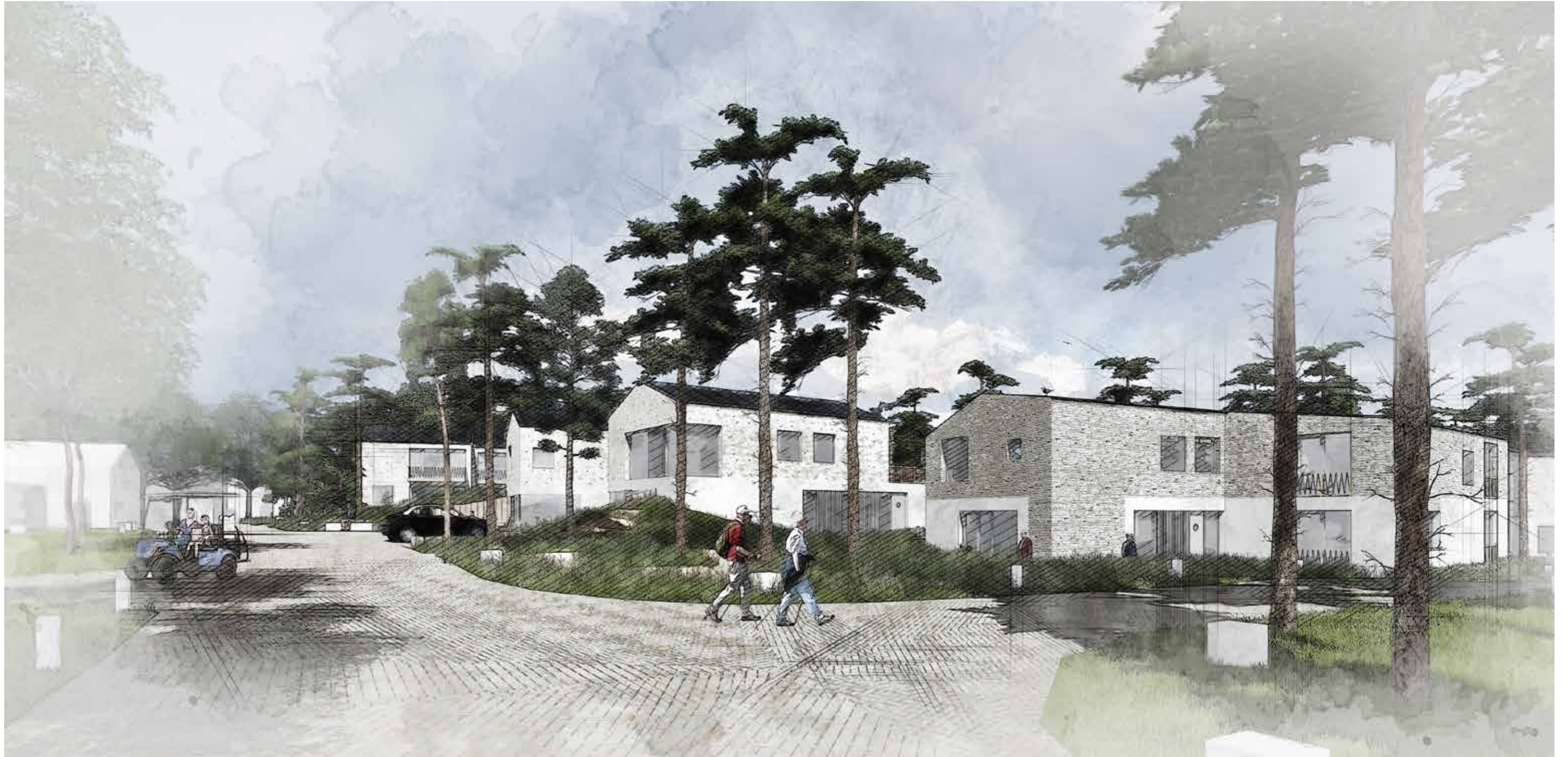
Zicht vanaf de Lutinelaan komend vanaf de boot
