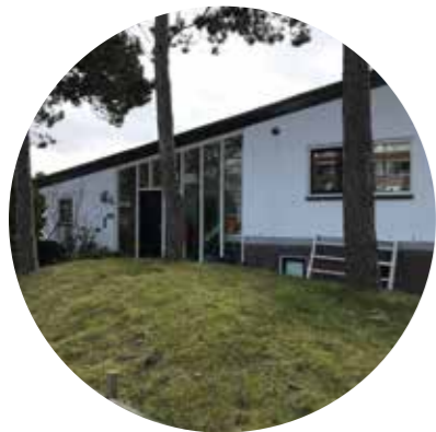
lichte bovenbouw, robuust basement
