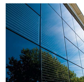
westgevel pv panelen
