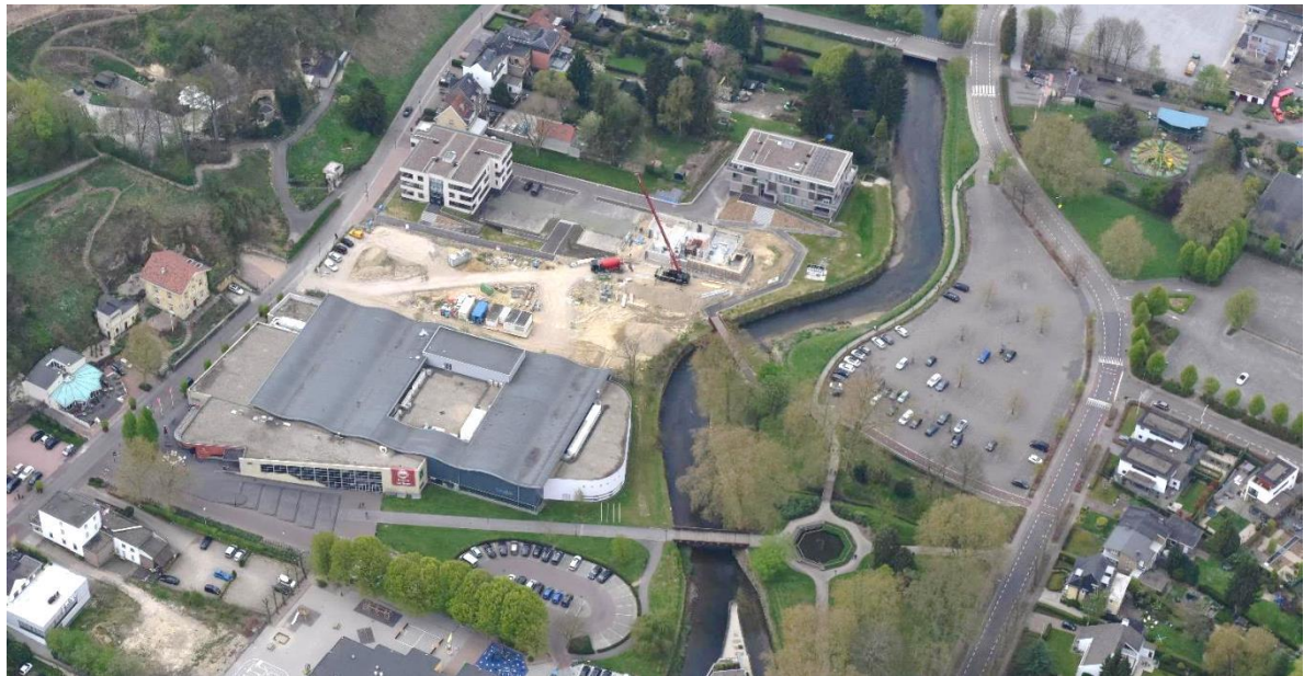
Figuur 2: luchtfoto locatie
