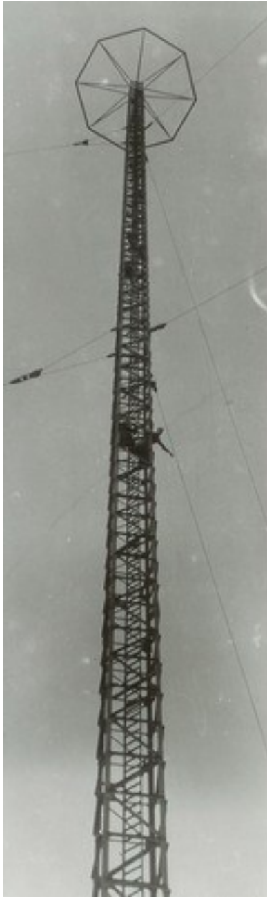
radiomast in HPP (in Tweede Wereldoorlog)
