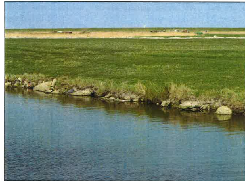
De tankval en één van de oevers met asbesthoudend puin
