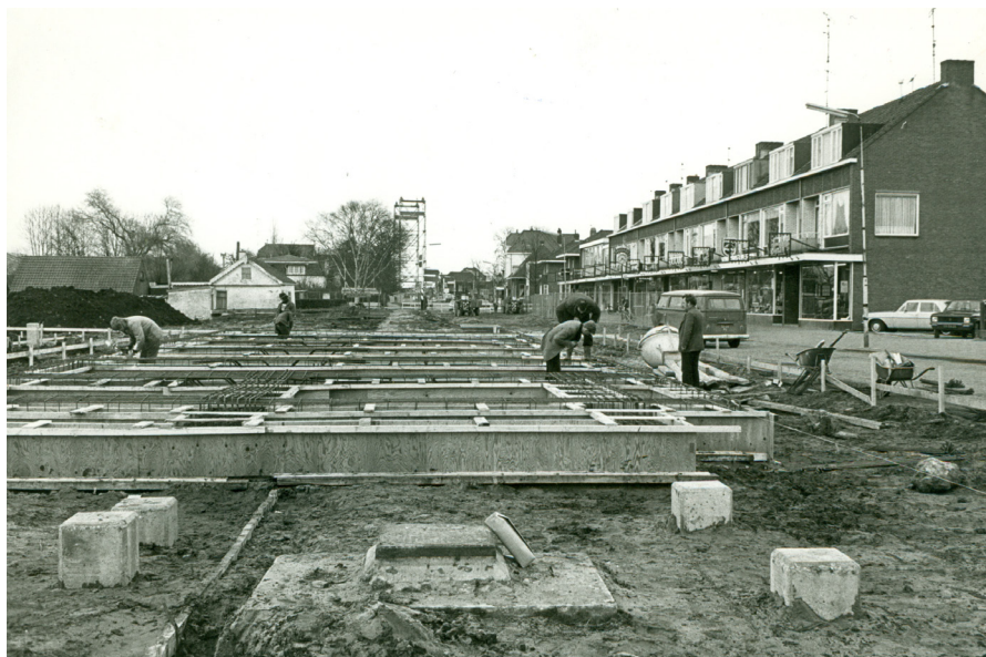
Figuur 19: De passage in aanbouw (1975)
