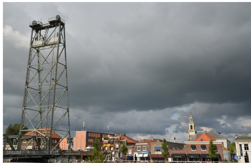
Figuur 7: Sterk punt: de hefbrug als entree (2016)
