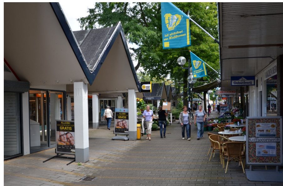
Figuur 20: De Passage in functie (2013)
