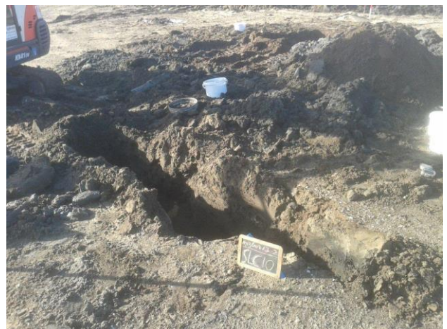
Foto 10: RE C3, sleuf SLC10
