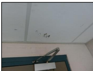
Beschadigde plafondplaat
