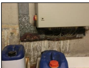
Gecorrodeerde goot
