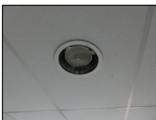
Aangetaste PL-armatuur
