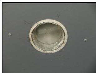
Aangetaste spot in luifel
