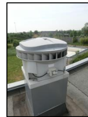
Uitgeschakelde afzuigventilator
