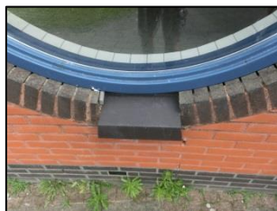
Houtrot en scheurtjes in kozijn
