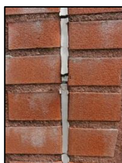
'Afbladeren' dilatatievoeg
