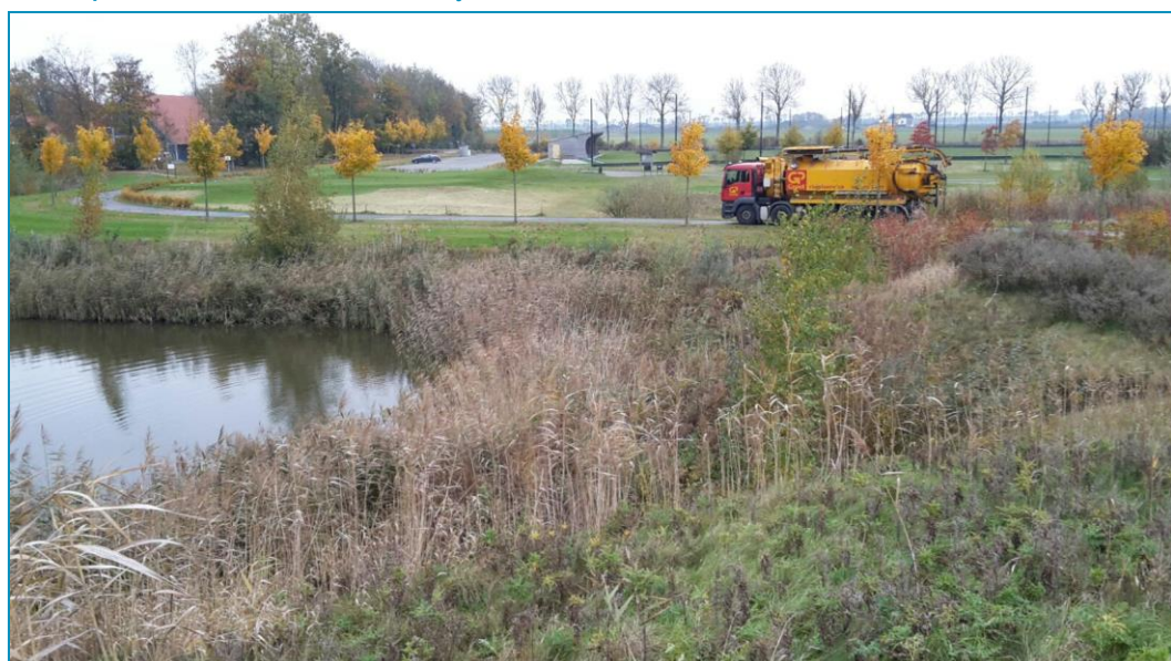
figuur 2 Riet ter plaatse van duiker aan noordoostzijde
