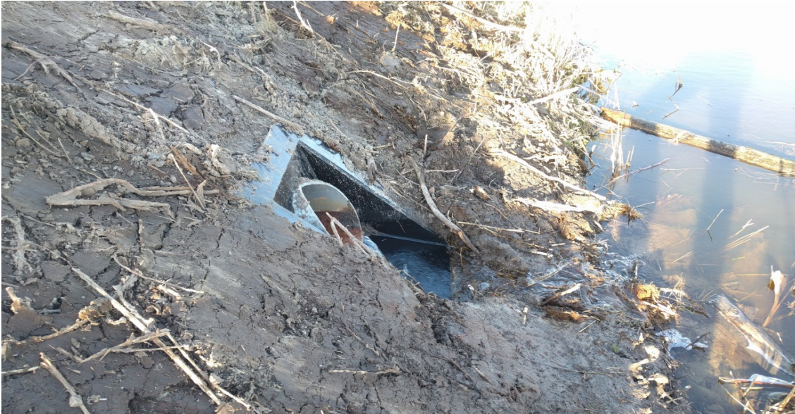
Herstelde uitstroomopening
