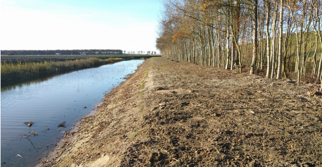
Opnieuw geprofileerd talud en uitgedunde bosschage aan zuidzijde
