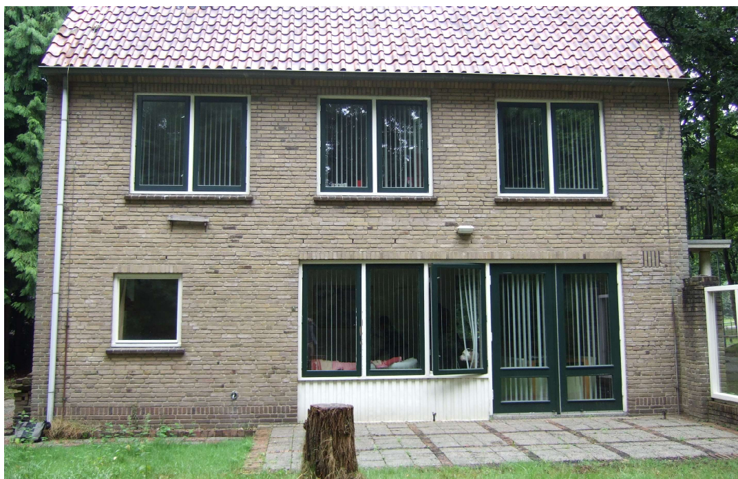
Zuidgevel en terrein woning Licht 119 ter plaatse van mogelijke afscherming
