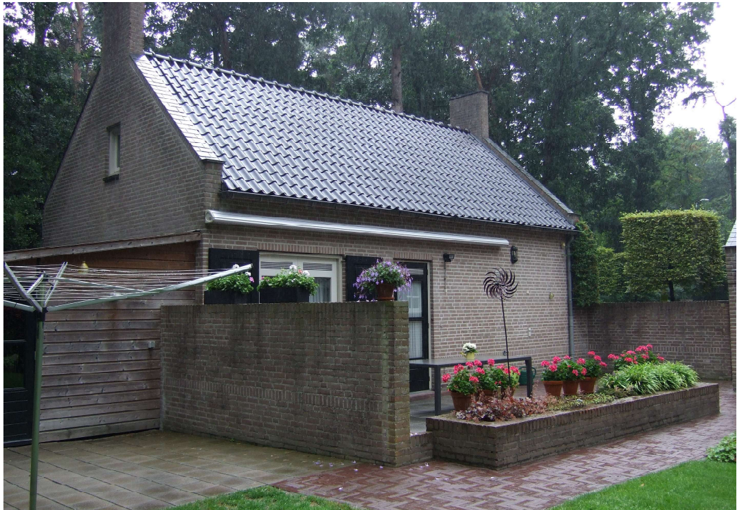
Terrein (N-zijde van woning Locht 68) ter plaatse van mogelijke alternatieve afscherming
