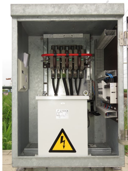
Figuur 4: Voedingskast 1-kabelsysteem met transformator
