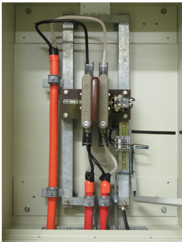
Figuur 7: 3kV-lastscheider (1-wegs) magnefix MA
