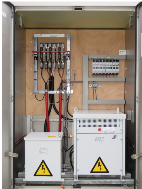
Figuur 5: Voedingskast 1-kabelsysteem met transformator en trafo-gelijkrichter
