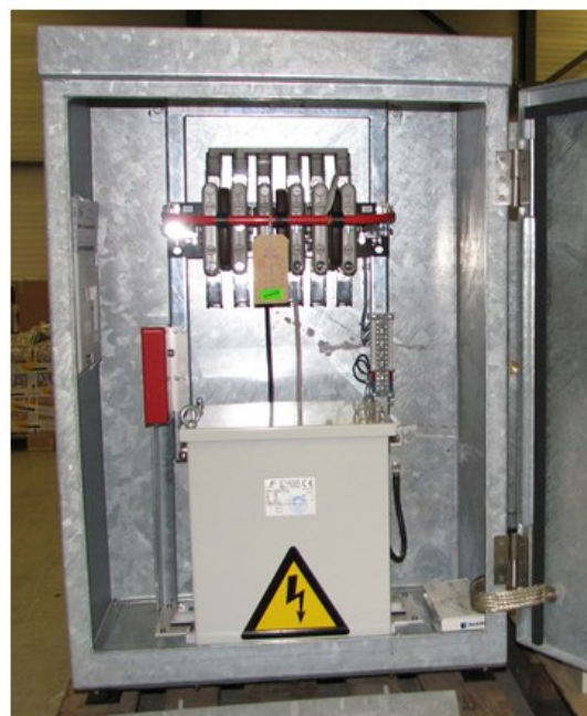
Foto 1 en 2. Links: buitenzijde 3kV-afnamepunt(1-kabelstelsel); Rechts: binnenzijde 3kV-afnamepunt (1-kabelstelsel)
