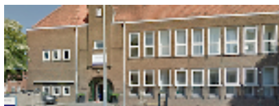
Horizon Mr. Schats Zuid Kastanjedaal 1 3075 LT Rotterdam Gebouw functie: SO Open: 40 wk p/j Frequentie: 200 dagen per jaar Vloeropp. ca. 1.213 m2 in onderhoud Vloeropp. ca. 2 m2 niet in onderhoud Glasoppervlak ca. 662 m2
