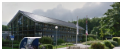
Horizon Centraal Bureau gebouw A Mozartlaan 150 3055 KM Rotterdam Gebouw functie: Kantoorlocatie Open: 51 wk p/j Frequentie: 255 dagen per jaar Vloeropp. ca. 782 m2 in onderhoud Vloeropp. ca. 0 m2 niet in onderhoud Glasoppervlak ca. 891 m2 (vervalt medio 2017)
