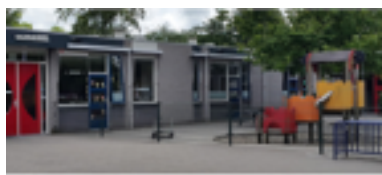
Horizon Gelinckschool oostvoorns Noordweg 14 3233 AV Oostvoorne Gebouw functie: SO Open: 40 wk p/j Frequentie: 200 dagen per jaar Vloeropp. ca. 1.653 m2 in onderhoud Vloeropp. ca. 44 m2 niet in onderhoud Glasoppervlak ca. 358 m2
