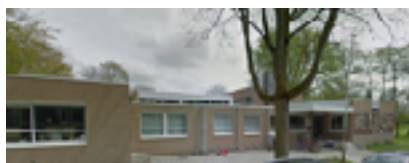
Horizon Parkcollege Dordrecht S.M. Hugo van Gijnweg 10 3317 JM Dordrecht Gebouw functie: VSO Open: 40 wk p/j Frequentie: 200 dagen per jaar Vloeropp. ca. 957 m2 in onderhoud Vloeropp. ca. 15 m2 niet in onderhoud Glasoppervlak ca. 818 m2
