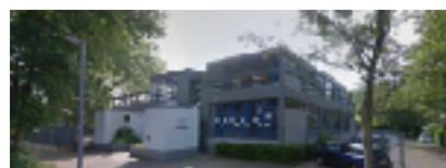
Horizon Mr. Schats Noord Van Enckevortlaan 129 3051 KR Rotterdam Gebouw functie: SO Open: 40 wk p/j Frequentie: 200 dagen per jaar Vloeropp. ca. 1.259 m2 in onderhoud Vloeropp. ca. 31 m2 niet in onderhoud Glasoppervlak ca. 1.120 m2
