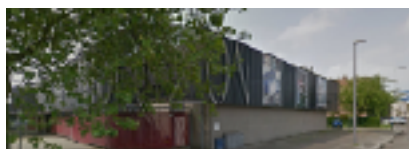
Horizon Educatief Centrum Schiemonddijk 8 3029 NP Rotterdam Gebouw functie: VSO Open: 42 wk p/j Frequentie: 210 dagen per jaar Vloeropp. ca. 302 m2 in onderhoud Vloeropp. ca. 0 m2 niet in onderhoud Glasoppervlak ca. 2.466 m2
