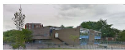
Horizon Schreuder College Taborstr Taborstraat 44 3061 EW Rotterdam Gebouw functie: VSO Open: 40 wk p/j Frequentie: 200 dagen per jaar Vloeropp. ca. 1.418 m2 in onderhoud Vloeropp. ca. 23 m2 niet in onderhoud Glasoppervlak ca. 706 m2
