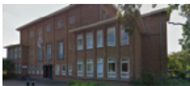
Horizon Kespercollege Gouda Nansenstraat 40 2806 HM Gouda Gebouw functie: VSO Open: 40 wk p/j Frequentie: 200 dagen per jaar Vloeropp.: ca. 1.012 m2 in onderhoud Vloeropp. ca. 0 m2 niet in onderhoud Glasoppervlak ca. 323 m2
