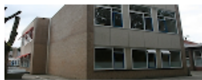
Horizon Bergseveltschool Mozartlaan 150 3055 KM KM Rotterdam Gebouw functie: SO Open: 40 wk p/j Frequentie: 200 dagen per jaar Vloeropp. ca. 1.481 m2 in onderhoud Vloeropp. ca. 0 m2 niet in onderhoud Glasoppervlak ca. 1.120 m2
