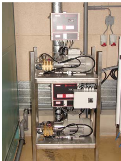
Voorbeeld van hogedrukpompen in duo-uitvoering.
