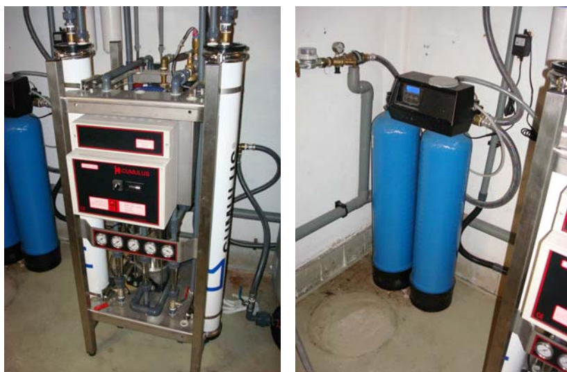
Bestaande Cumro 500 omgekeerde-osmose unit en 2x 20 liter waterontharder
